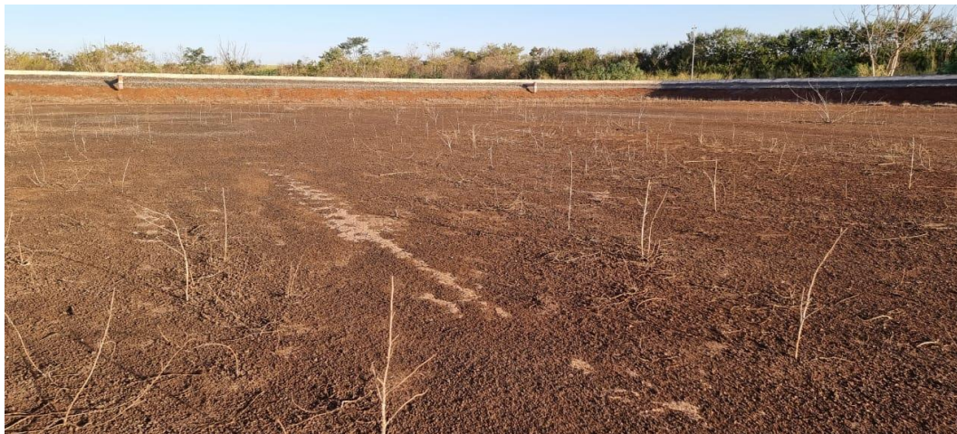
Figura 10. Vista do fundo da lagoa facultativa 1 com presença de arbustos.
