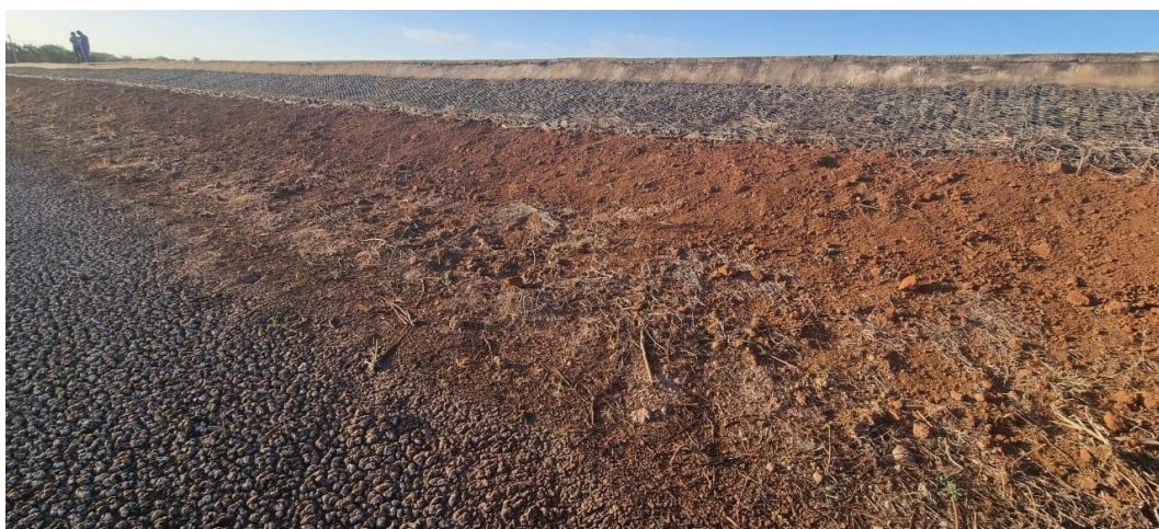
Figura 12. Detalhe do talude interno da lagoa facultativa 1.
