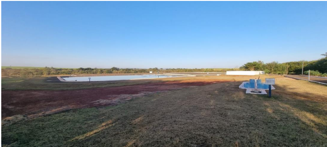
Figura 4. Vista geral da ETE Cruz das Posses.
