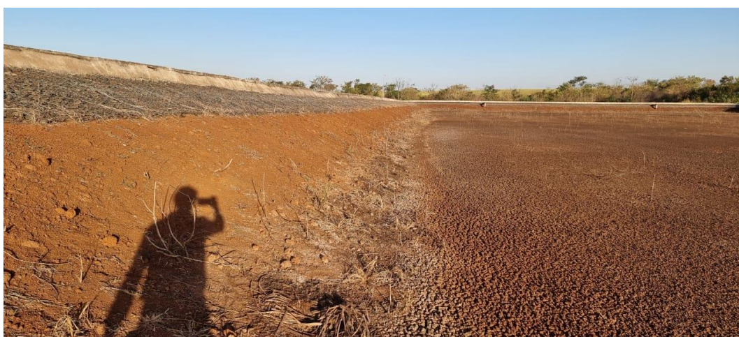
Figura 9. Vista do talude interno da lagoa facultativa 1.
