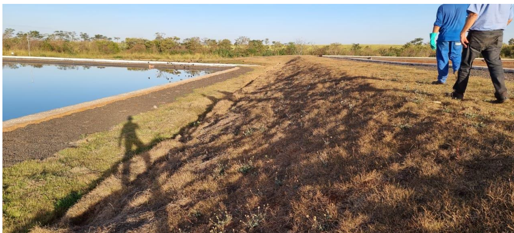
Figura 7. Vista do talude entre as lagoas facultativas 1 e 2.
