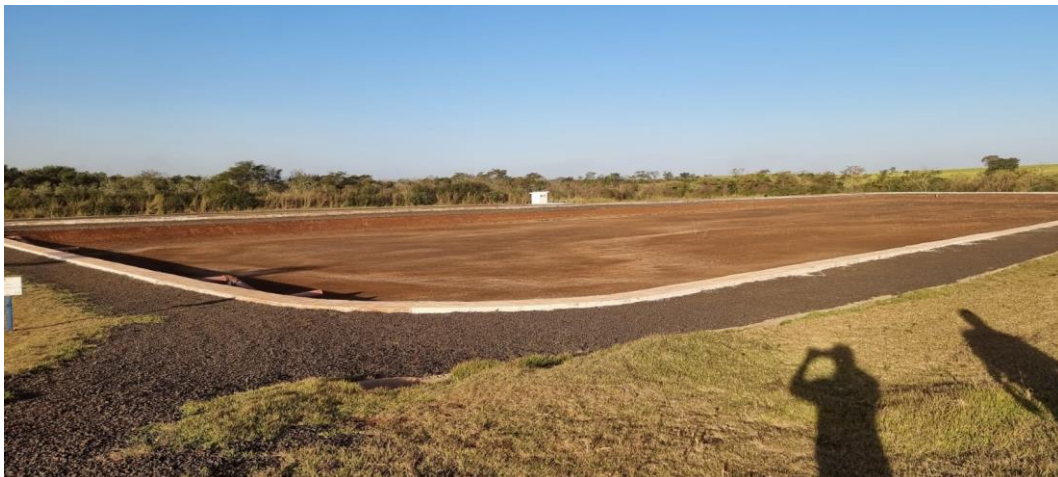
Figura 5. Vista da lagoa facultativa 1.
