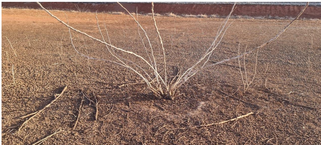
Figura 11. Vista do fundo da lagoa facultativa 1 com presença de arbustos.
