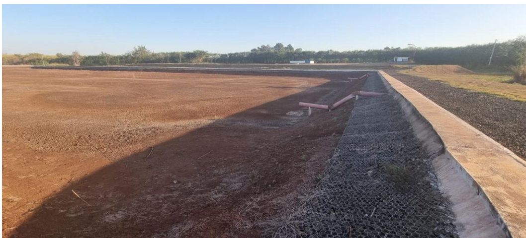
Figura 6. Vista da lagoa facultativa 1.
