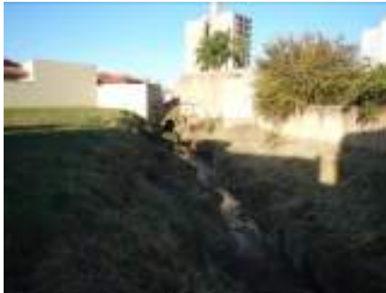
Figura 15 – Moradias de alto padrão construtivas próximas às margens.
