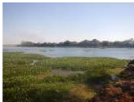
Figura 21 – Represa da Usina de São Geraldo.
