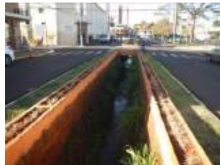
Figura 12 – Água Vermelha canalizado na Av. Dr. Antônio Furlan Jr.
