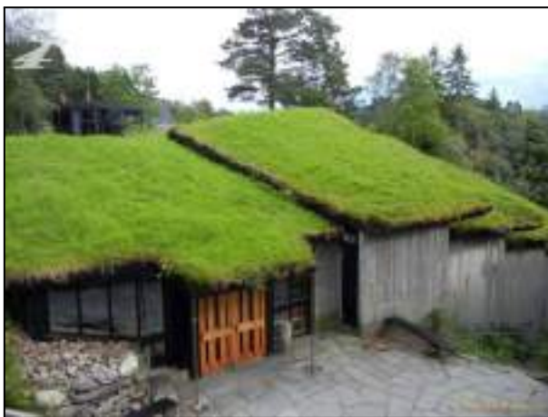
Figura 58 – Detalhe de telhado ecológico
