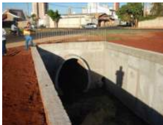
Figura 23 – contenção de margens do desemboque do Córrego do Norte no Córrego do Sul ou do Sertãozinho.
