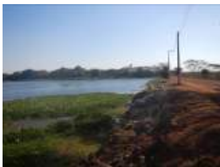
Figura 20 – Barragem da Represa da Usina de São Geraldo.
