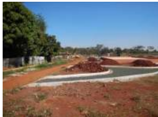
Figura 29 – A construção contemplou a construção de sistema de esgoto e drenagem superficial para o bairro.
