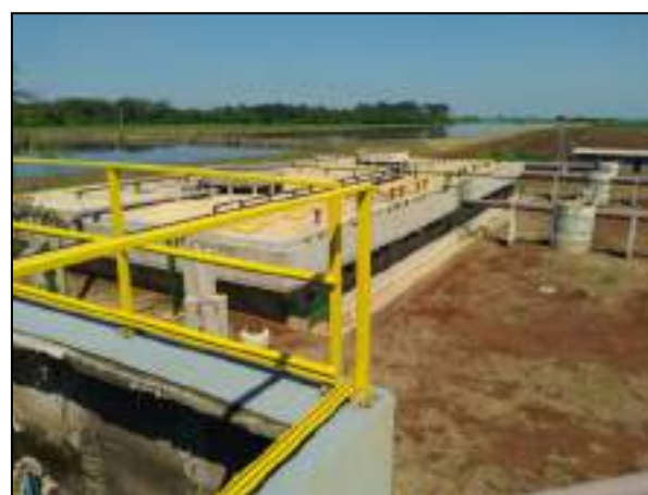
Fig. 30.2 - Caixa de areia e decantador
