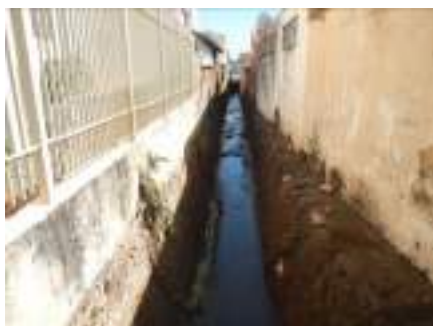
Figura 13 – Moradias sem recuo para as margens do Córrego do Norte.
