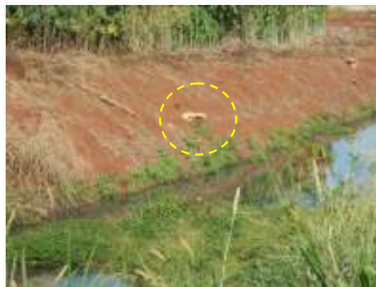
Figura 6 – manilhas para lançamento de águas servidas e de esgoto no Córrego do Norte.
