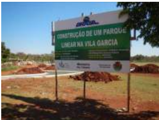
Figura 28 – Identificação das obras em andamento para construção de um Parque Linear na Vila Garcia.
