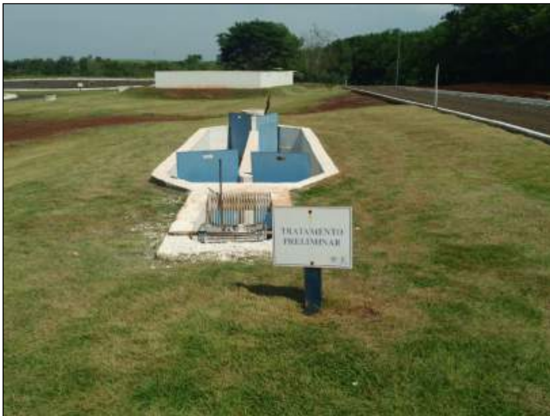
Figura 29 – Tratamento preliminar - Gradeamento
