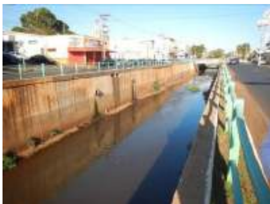
Figura 22 - Intervenções estruturais no Rio do Sul, Macrodrenagem. Local com histórico de enchentes e inundações.
