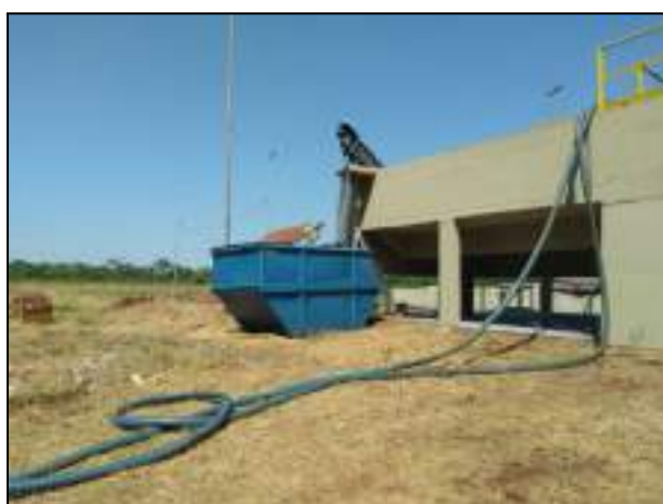
Fig. 30.1 - Caçamba - sólidos do tratamento preliminar
