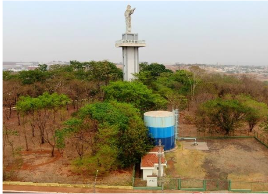
Figura 5– Fiscalização com drone do reserv. P42.
