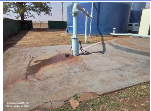
Figura 12- Fiscalização presencial no poço P27.
