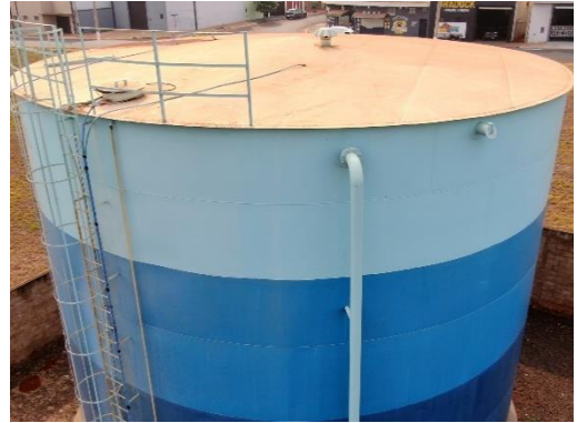
Figura 6–Fiscalização com drone do reservatório P45.
