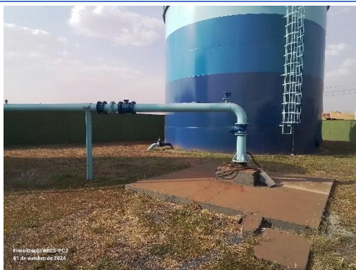
Figura 15- Fiscalização presencial no poço P41.
