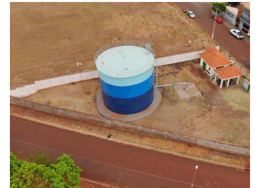
Figura 8– Fiscalização com drone do reservatório P50.
