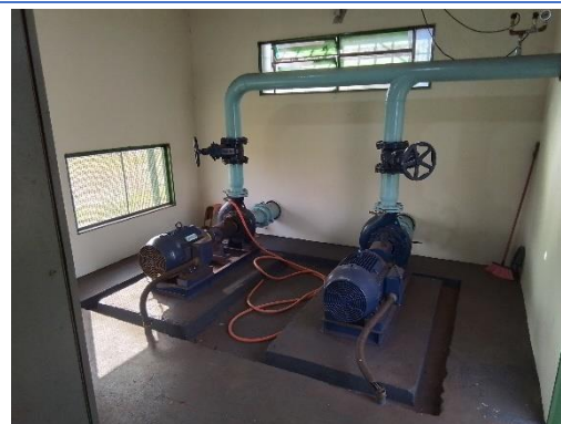
Figura 16- Fiscalização presencial na EEA P41.
