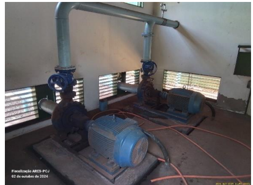
Figura 10- Fiscalização presencial na EEA P35.
