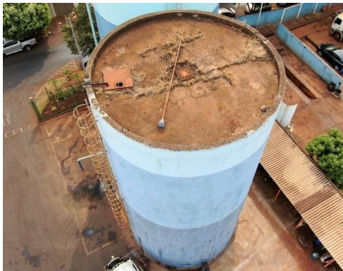
Figura 7– Fiscalização com drone do reserv.P49.
